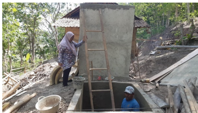
Gambar 11. Perbaikan Jamban Tidak Layak
