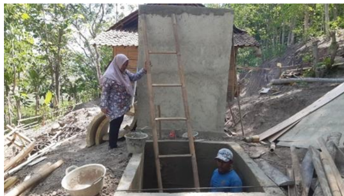
Gambar 11. Perbaikan Jamban Tidak Layak
